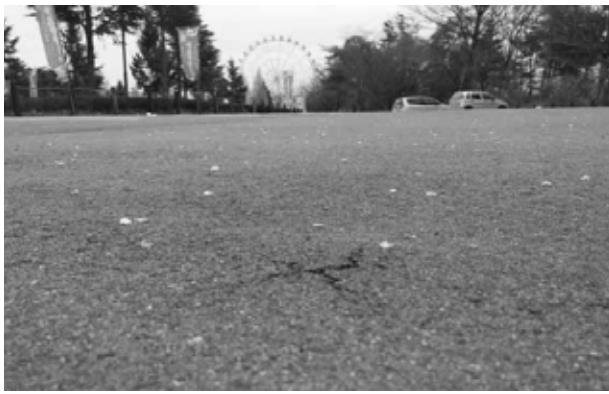
ひび割れが始まった駐車場
