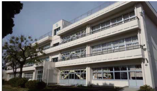
1期工事が終了した南校舎
