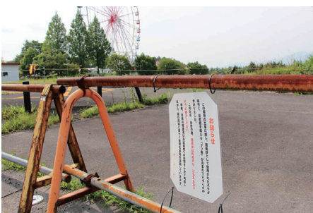
閉鎖されているスカイランドパーク第4駐車場
