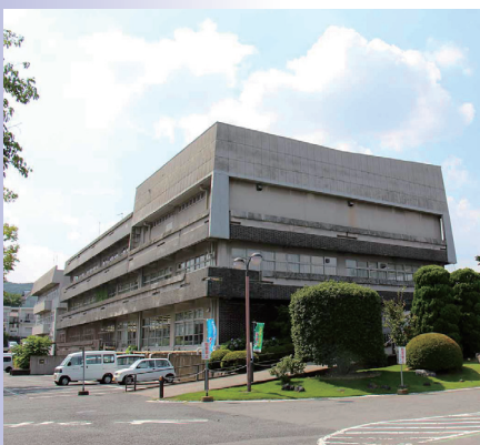
渋川市役所本庁舎
