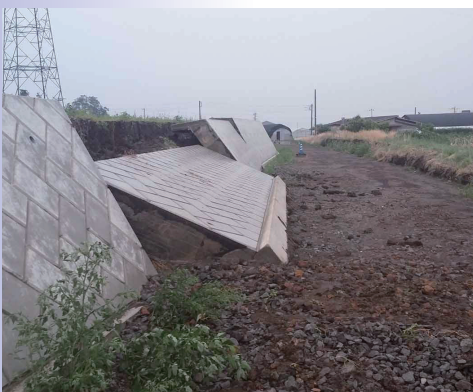
擁壁が崩れた（仮称）北橋運動場
