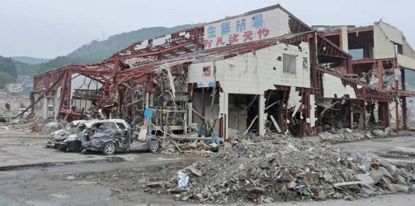
東日本大震災：宮城県女川町の様子(本市被災地派遣職員撮影)
