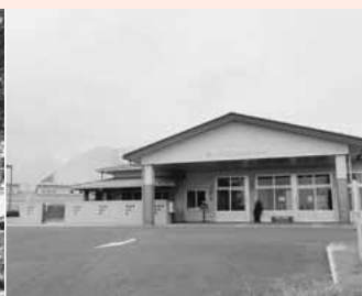
北橋地区/改築整備された 北橋幼稚園
