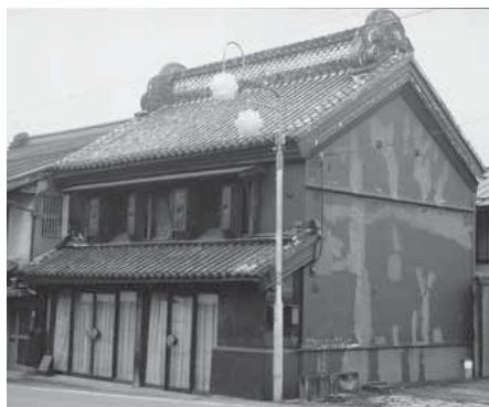
堀口家住宅店蔵・主屋・北蔵・南蔵・付属屋 (渋川地区)
