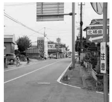
北橋町真壁地内の歩道
