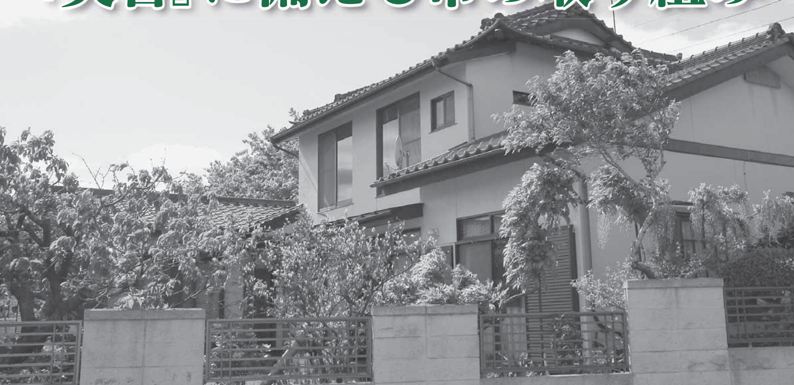
平成21年度に耐震診断を受けた住宅
