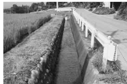
整備済みの地区の水路
