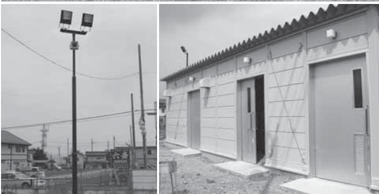
建設が進む多目的交流建物(上) 公衆トイレも設置されます(右下) 各種イベント開催に対応するための照明(左下)
