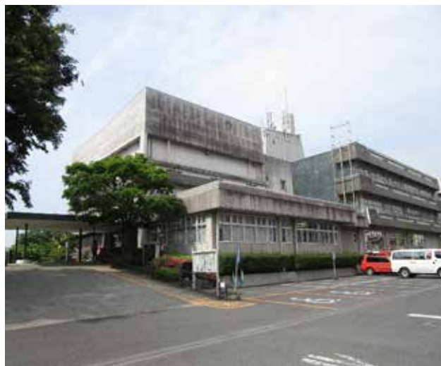
老朽化の進む市役所本庁舎
