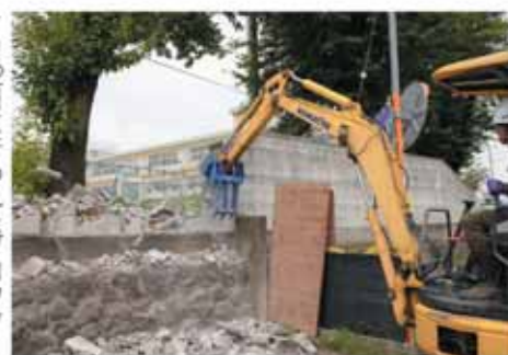
7月12日に行われたブロック塀の撤去作業（古巻小学校）
