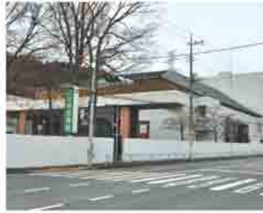
工事が進む市民会館
