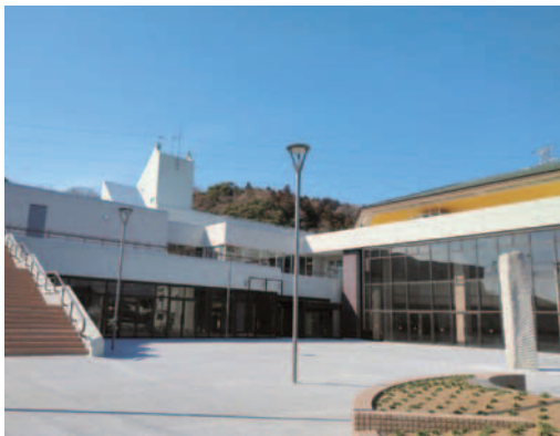
改装になった市民会館
