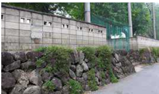
撤去される洪中のブロック塀
