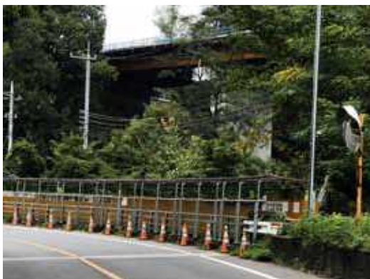
通学路となっている仮設道路
