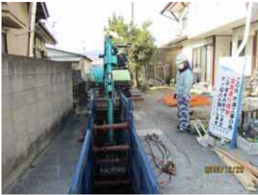
着々と進む下水道事業（半田地区）
