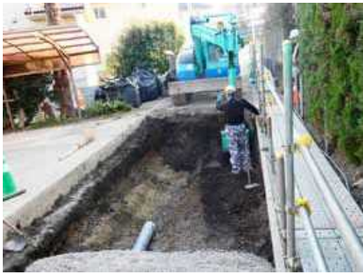
汚染土壌の撤去が進む金井の市道
