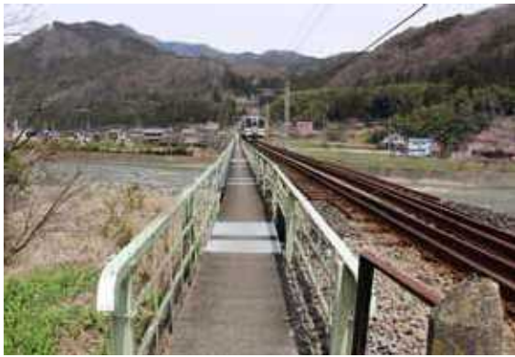
地域が早期建設を望む吾妻川橋りよう2
