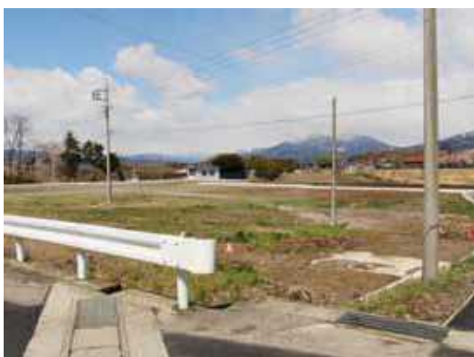
(仮称)東部学校給食共同調理場建設予定地
