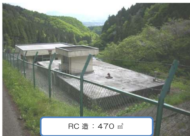
1 小野子配水場
