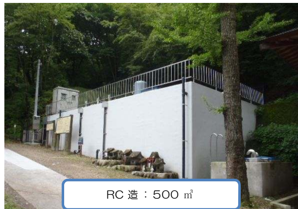
5 伊香保神社配水池
