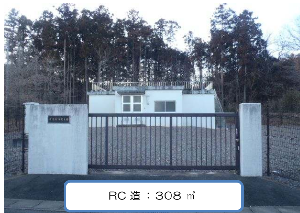
3 有馬塚内配水場
