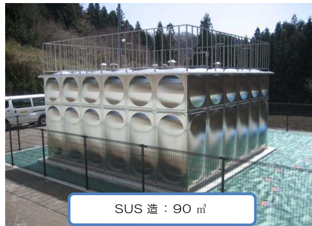
6 低区第2配水池
