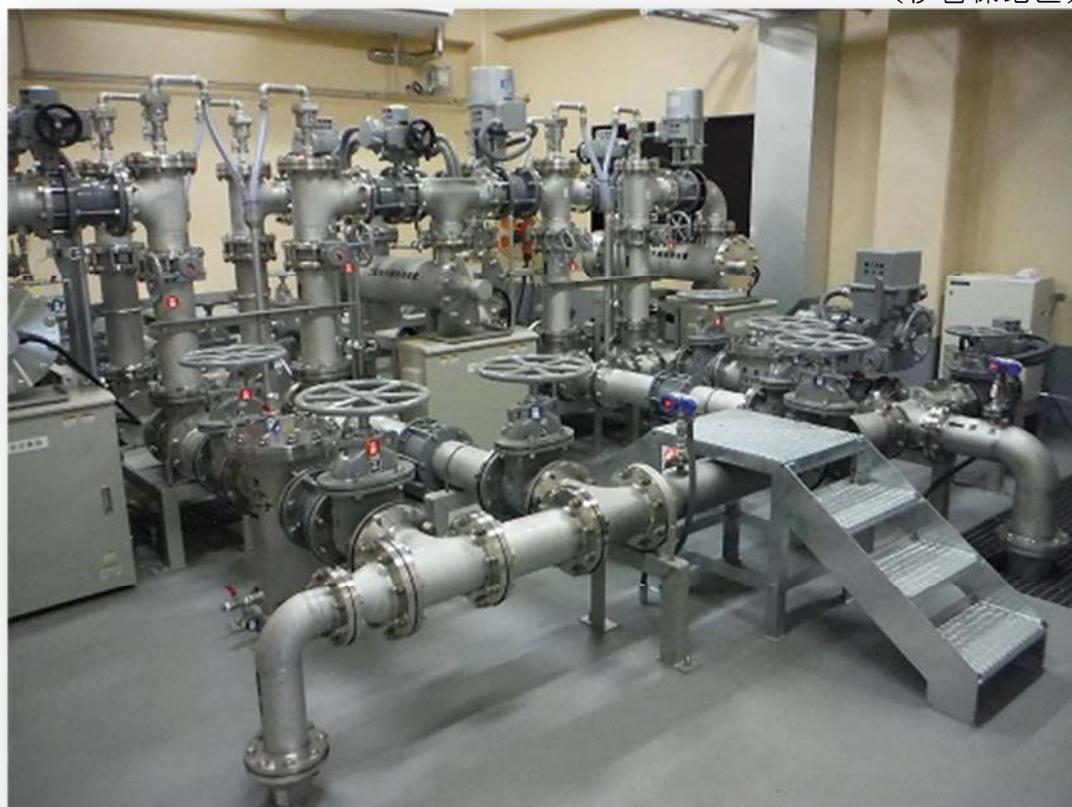
西沢浄水場 (紫外線処理装置)
