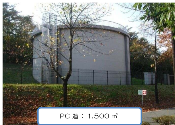
19 渋川大野配水池
