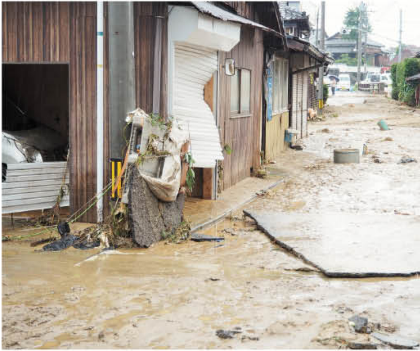
平成29年7月北九州北部豪雨の土砂災害
