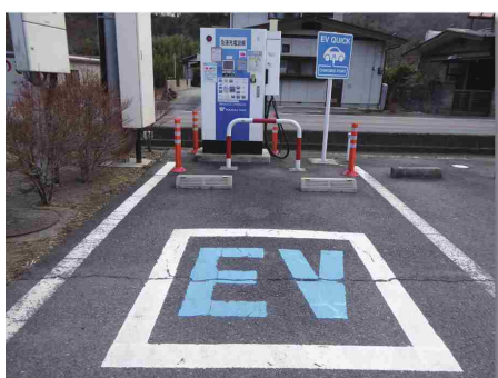
電気自動車充電器（道の駅おのこ）
