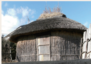
復元された中筋遺跡の平地建物
