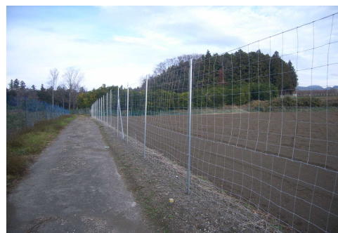
侵入防止柵 （金網柵）
