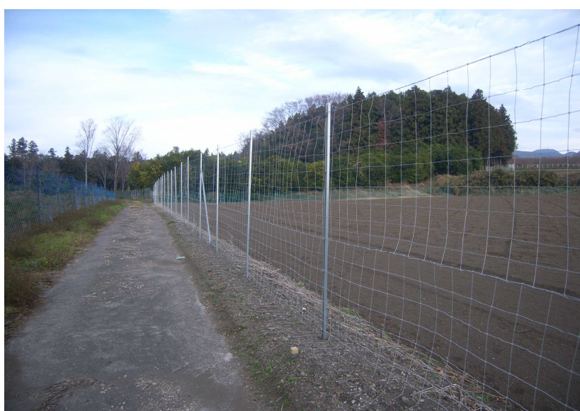
侵入防止柵（金網柵）の設置作業と完成後（赤城地区）
