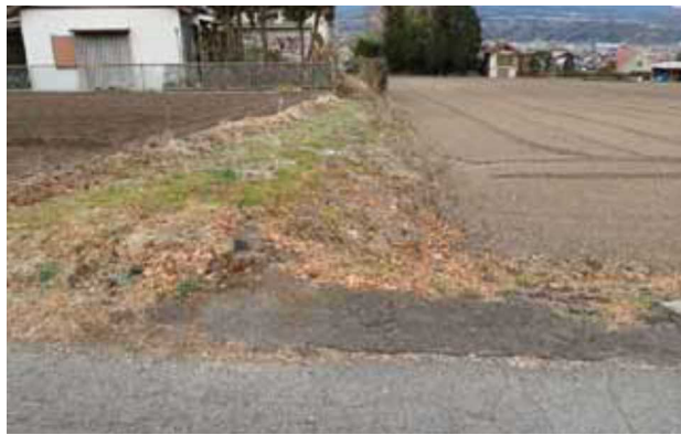
市道1-5400号線の現状
