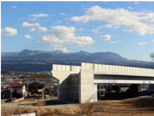
建設中の上信自動車道
