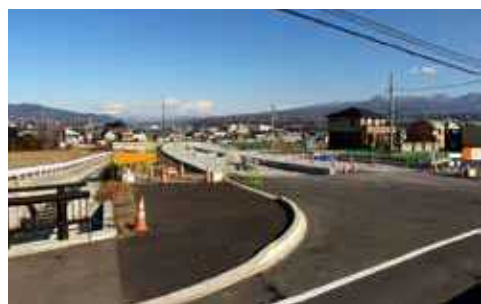
高渋バイパス取付道路
