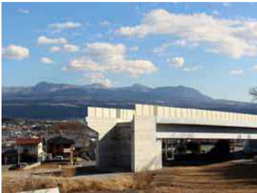
建設中の上信自動車道
