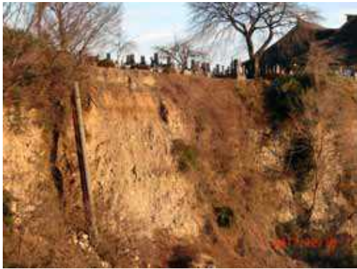
崖崩落により排水管露出
