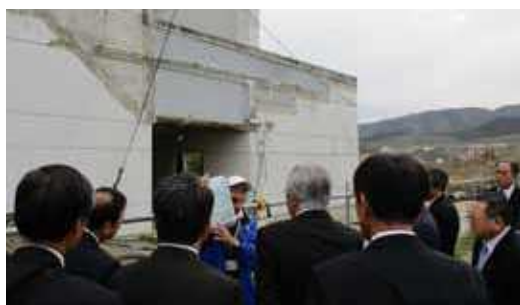
陸前高田市の被災施設
