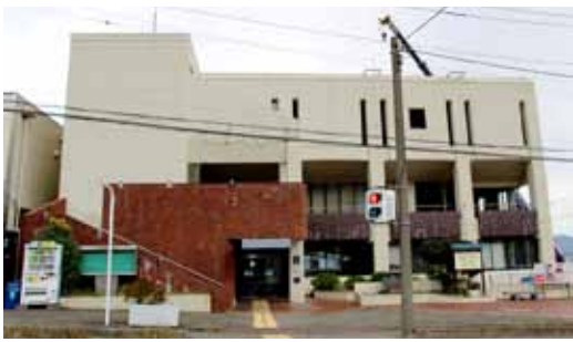
解体予定の旧伊香保行政センター
