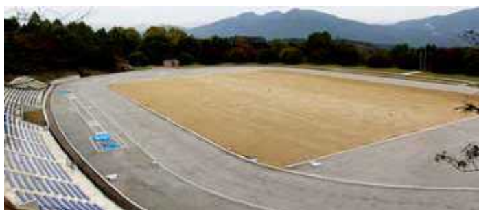
改修中の渋川総合公園陸上競技場
