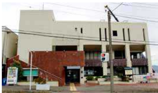
解体予定の旧伊香保行政センター
