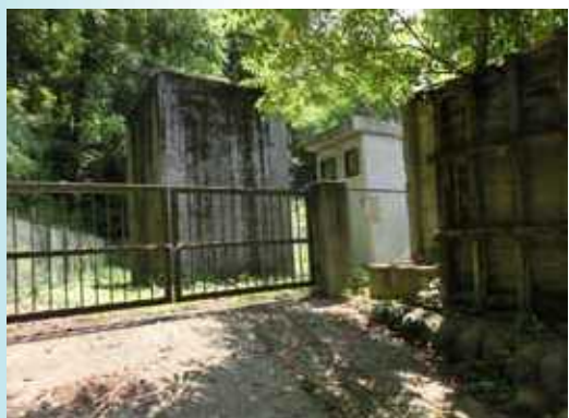
水道水源地（金井地内）
