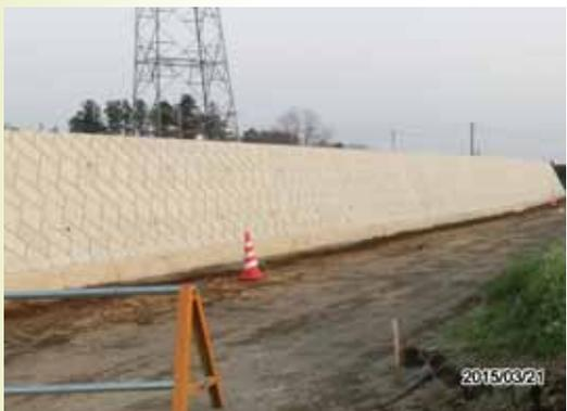
基礎が露出している北橋運動場の擁壁
