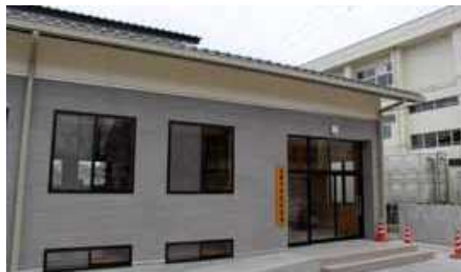
新設された古巻中学校武道場
