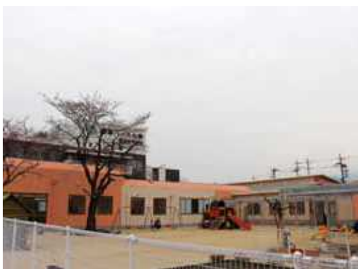
3階の活用が望まれるすこやかプラザ
