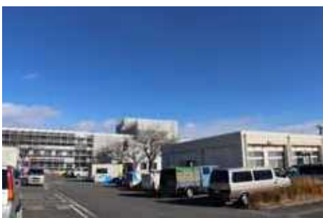
改修中の子育て支援総合センター
