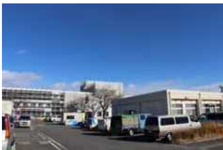
改修中の子育て支援総合センター
