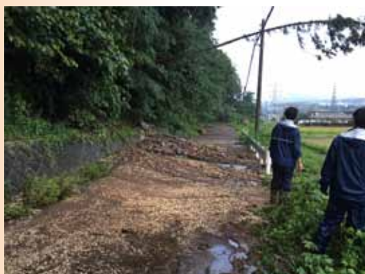
大雨による土砂災害
