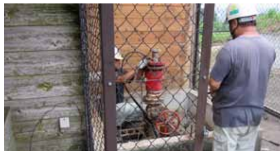
交換された湯湯ポンプ
