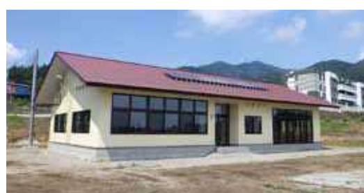
小野上地区に建設された環境学習多目的施設
