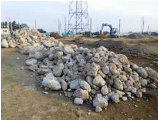
不法搬入された土石とソイルセメント
