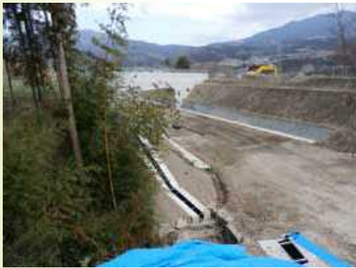
上信自動車道建設現場
