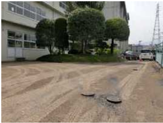
改修工事が始まった古巻小学校
