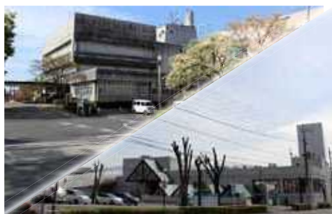
老朽化が進む庁舎
