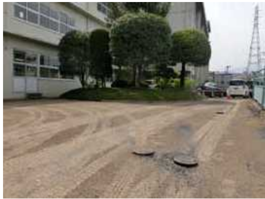
改修工事が始まった古巻小学校
