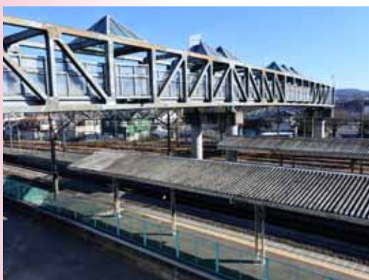
渋川駅東西連絡橋
