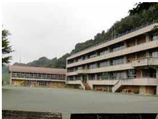
有望利用が望まれる廃校舎
