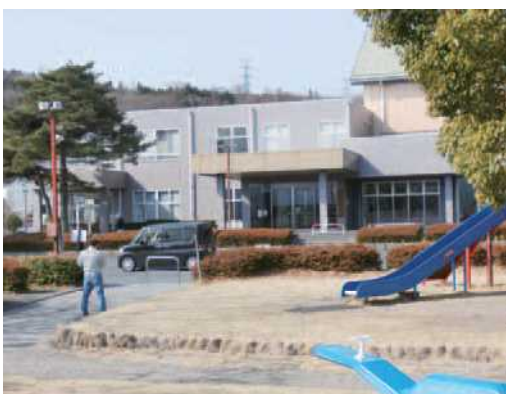
金島ふれあいセンター空調整備は早く
