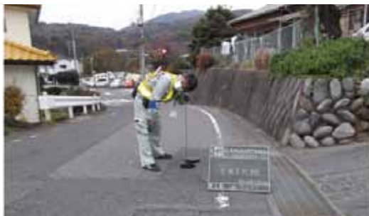
漏水検査の様子
