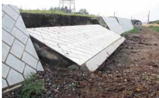
擁壁が崩れた(仮称)北橋運動場
